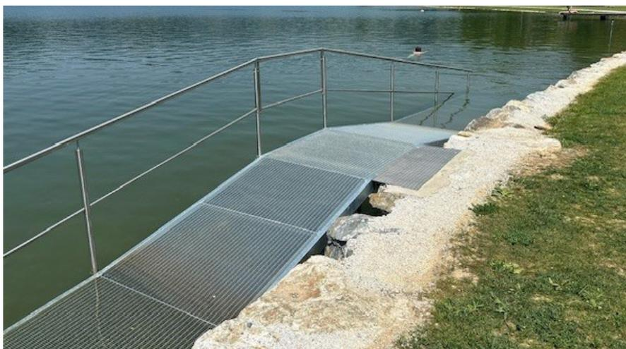
Im Bereich des Beach Clubs wurde eine **Steinschlichtung** errichtet. Um den Zugang zum Wasser zu erleichtern wurden zwei **behindertengerechte Rampen** montiert.
