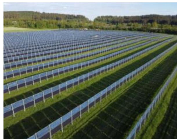
Abbildung 25: Agri-PV in Verbindung mit Nutztierhaltung (links) [photovoltaik.eu](http://photovoltaik.eu); Agri-PV mit senkrechten Modulen zur beidseitigen Stromproduktion (rechts), [maxx-solar.de](http://maxx-solar.de)
