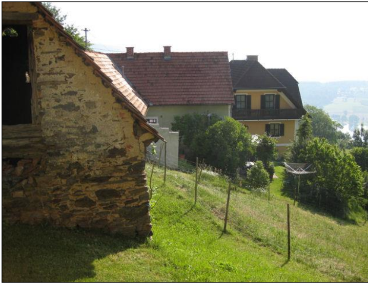
Lücke (Blick Ost)
